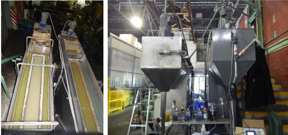
**Figuras 15 y 16:** En la primera vista se observa el par de sedimentadores lamelares, el ubicado a la izquierda es el que trabaja pH 2, mientras el de la derecha trabaja a pH 11. En la segunda vista se observa el frente de ambos sedimentadores donde ubicamos las bombas dosificadoras de reactivos coagulantes floculantes y neutralizantes.
