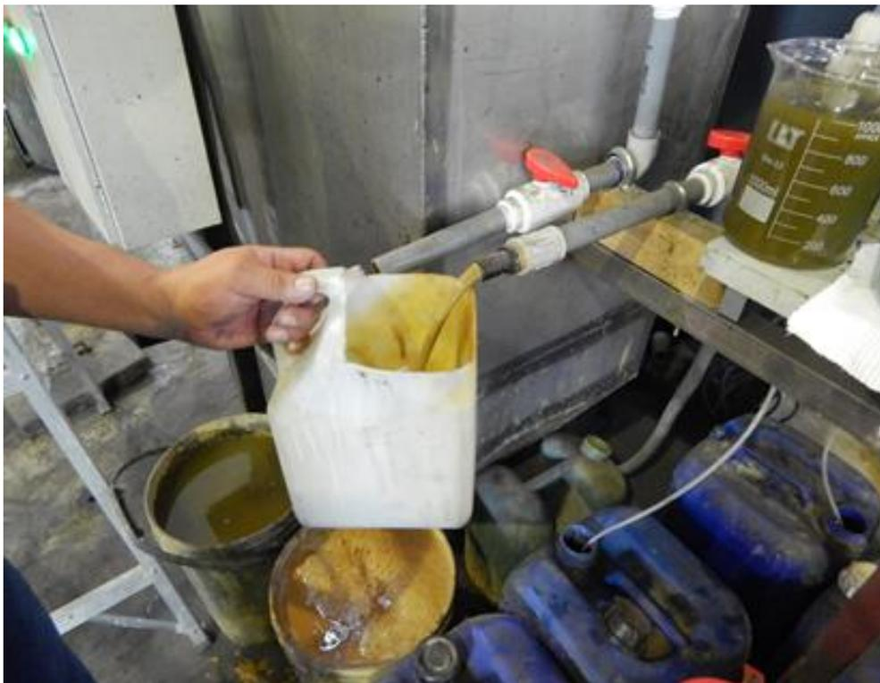
**Figura 19:** Se observa en el preciso momento que se realiza una de las purgas manuales para eliminar los lodos que se generan en el tratamiento
